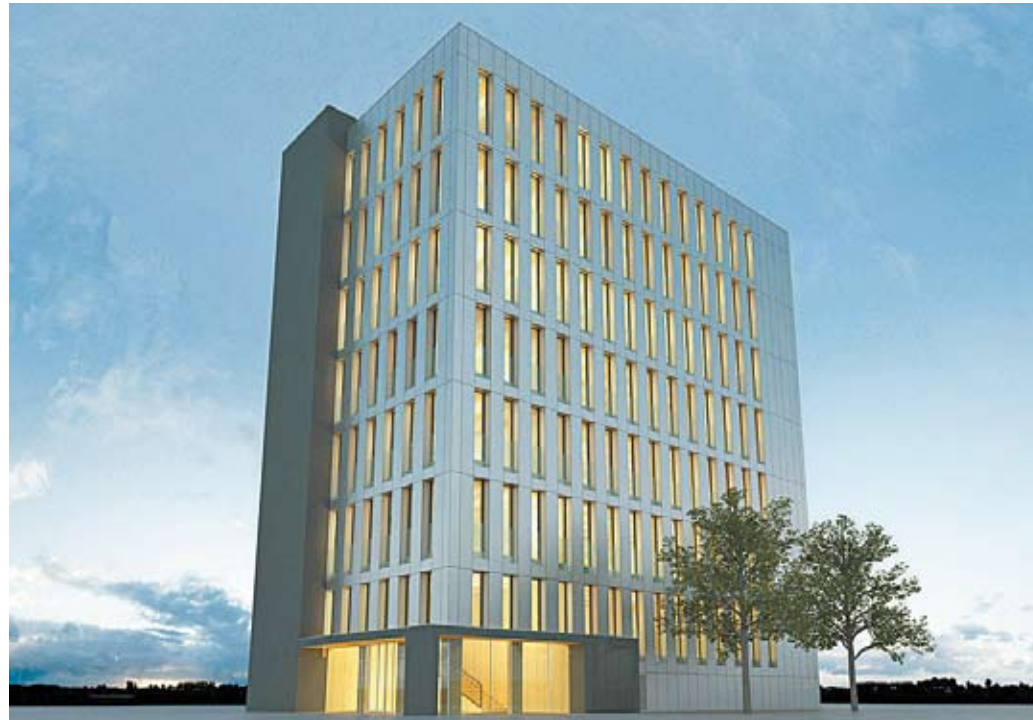
Vorbild für modernes, nachhaltiges Bauen und richtungweisend für die zukünftige Entwicklung der Baubranche: LCT One, der erste LifeCycle Tower, wird aktuell in Dornbirn gebaut.
