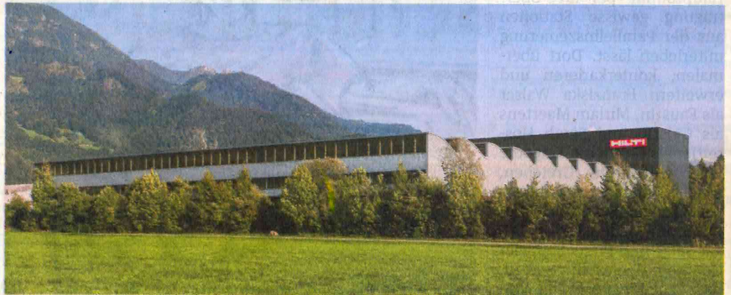
Hilti Thüringen wurde als erster Industriebau mit dem ÖGNI-Zertifikat in Silber ausgezeichnet.
