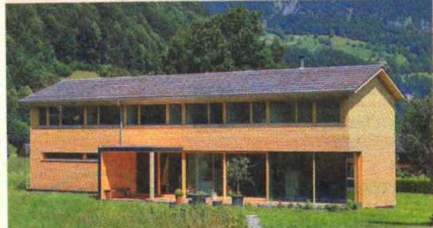
Nachhaltig errichtete Gebäude wie Passivhäuser gewinnen immer mehr an Bedeutung.
