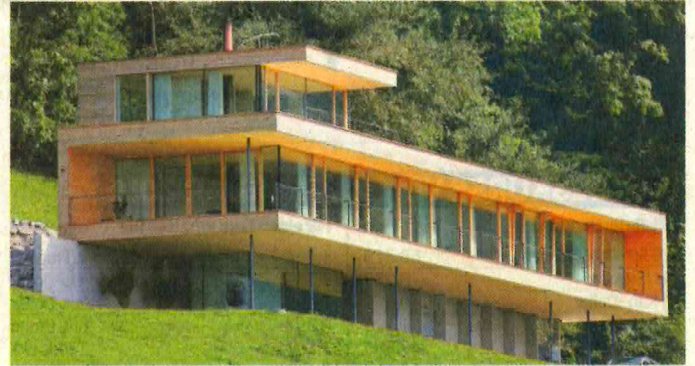
Nachhaltiges Bauen hat in Vorarlberg schon lange einen besonders hohen Stellenwert.
